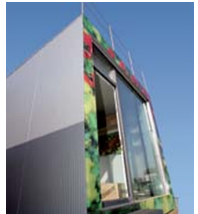
Mikrohaus Loft - Wien (Austria)
